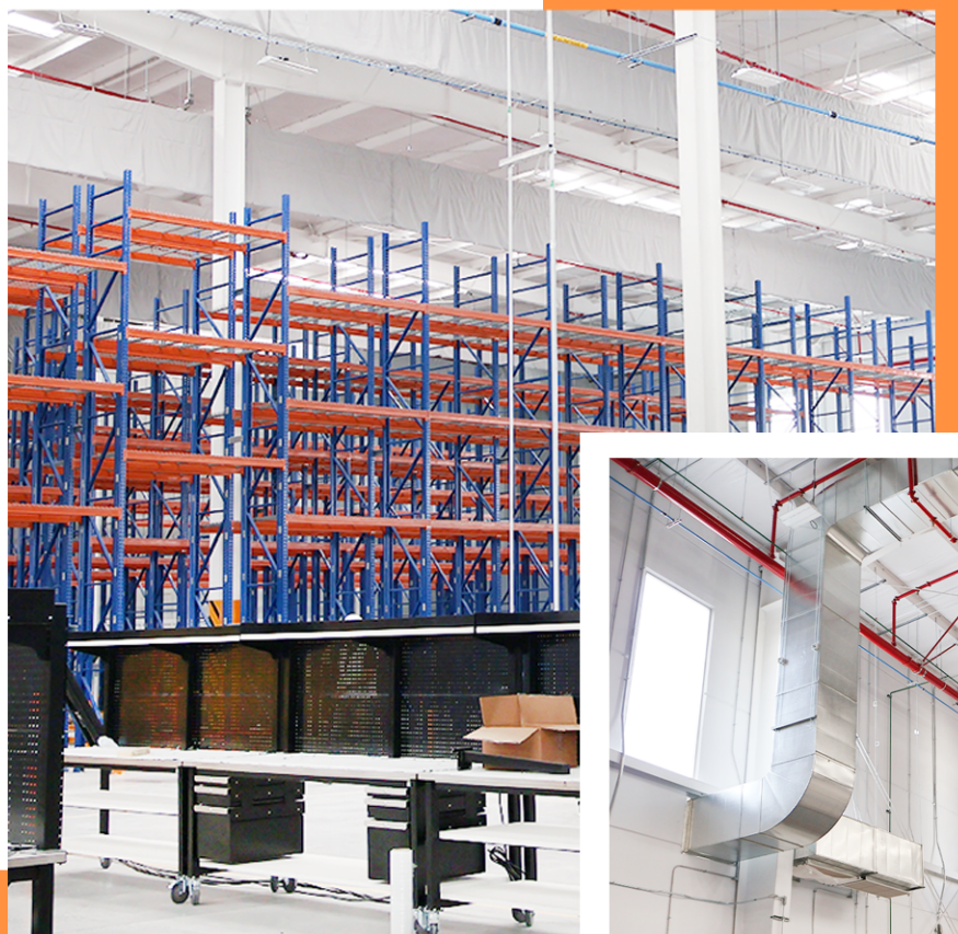
Líneas de producción y área de racks
